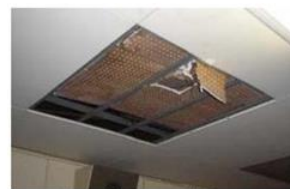
天井材の落下・剥がれ
