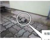
地盤の沈下によるインターロッキングブロックの陥没の事例 | <ul style="list-style-type: none"> <li>●人が通行する箇所は、高齢者等がつかずき、転倒する場合があります。緊急措置が必要な場合は、三角コーン等を使用し、注意喚起をしましょう。</li> <li>●地盤沈下や地下埋設管からの漏水や損傷など大きな不具合が隠れている場合があります。常に水溜まりになっている地盤では、漏水の可能性も疑われます。</li> </ul> |    |
