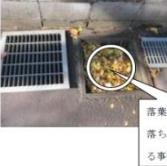
落葉期の集水ますに落ち葉がたまっている事例     | <ul style="list-style-type: none"> <li>●集水ますは、特に土砂が溜まる構造となっています。砂利の底が見え、水が抜ける状態が正常です。定期的に周りの落葉や土砂は取除くようにしましょう。</li> <li>●普段は大丈夫と思っても、ゲリラ豪雨等時には被害が拡大する可能性があります。大雨の予報の際には、ふたが外れていないかも確認しましょう。</li> </ul> |    |
