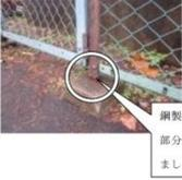
鋼製フェンスの柱脚部分の腐食に注意しましょう。   | <ul style="list-style-type: none"> <li>●特に、一般道路や普段利用者が通行する通路に面している場合は、要注意です。</li> <li>●ネットフェンスの針金が飛び出ている場合は、通行などの際のケガにつながる場合があります。</li> <li>●鋼製フェンス、門、駐輪場、外灯などの支柱の根本部分の腐食を注意して点検しましょう。</li> </ul>      |    |
