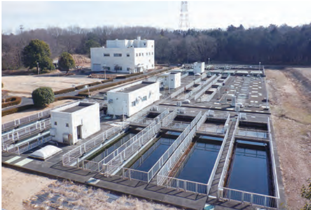
〈下水道処理施設〉
