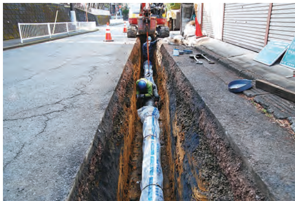
〈水道管の更新工事〉
