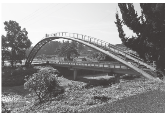
〈出世橋水管橋〉
