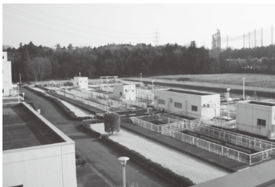
〈下水道処理施設〉
