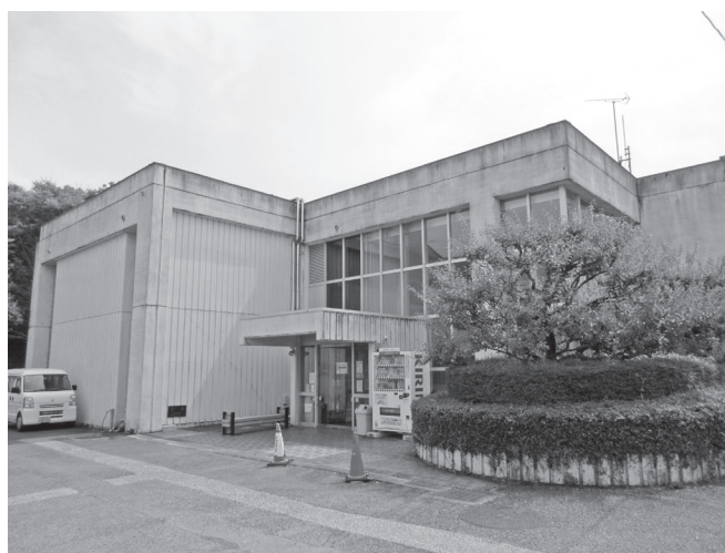
改修予定の武蔵台公民館
