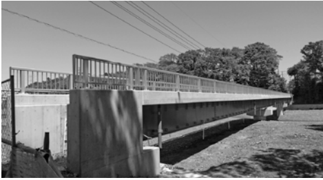
完成間近な久保の下橋
