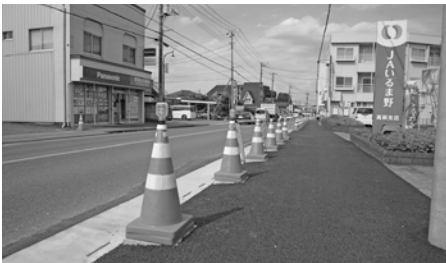
バリアフリー安全対策工事
