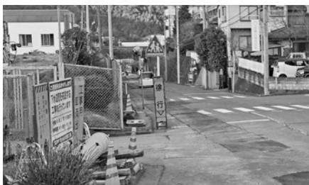
武蔵台地区で進む下水道管布設工事
