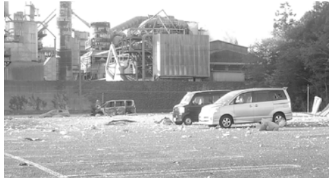
プラント周辺の被害状況
