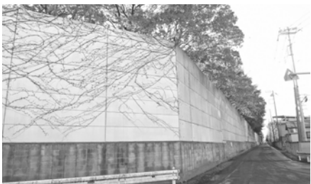
安全性が確認された防音壁
