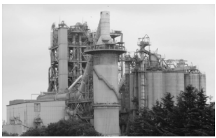
太平洋セメント（株）埼玉工場
