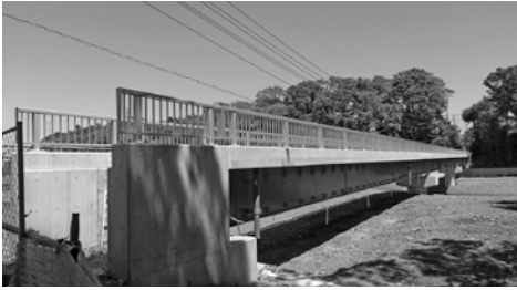
完成間近な久保の下橋
