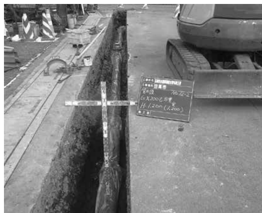
▲水道管の耐震化(例) GX形ダクタイル鋳鉄管 口径200ミリメートル
