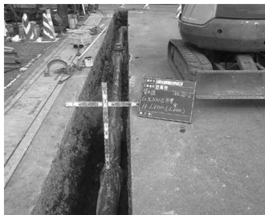
▲水道管の耐震化(例) GX形ダクタイル鋳鉄管 口径200ミリメートル
