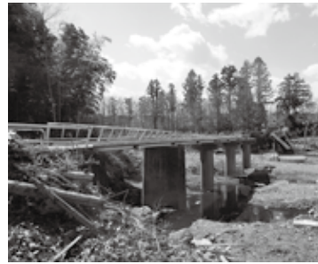
▲橋の倒壊(新堀-野々宮地内)
