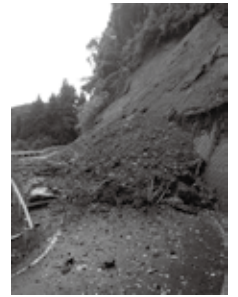
▲土砂崩れ (高麗本郷地内)
