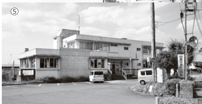
①旧高萩公民館 ②旧高萩公民館竣工当時の職員 ③優良公民館表彰状 ④公民館結婚式 ⑤前高萩公民館
