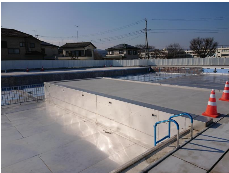
50mプール 25mプール・20mプール (工事中)
