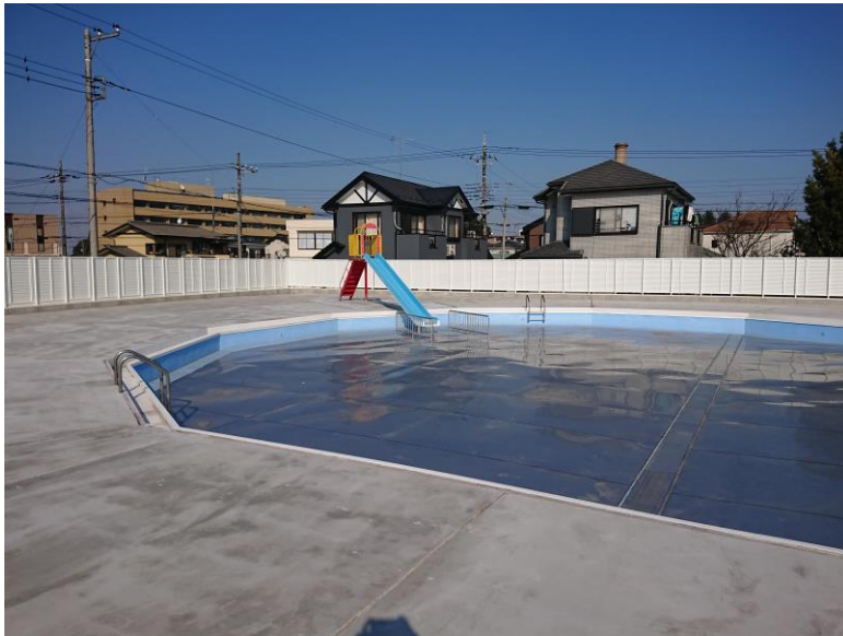
幼児用プール(工事中)
