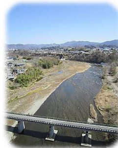
秩父公園橋の下には 荒川が流れている
