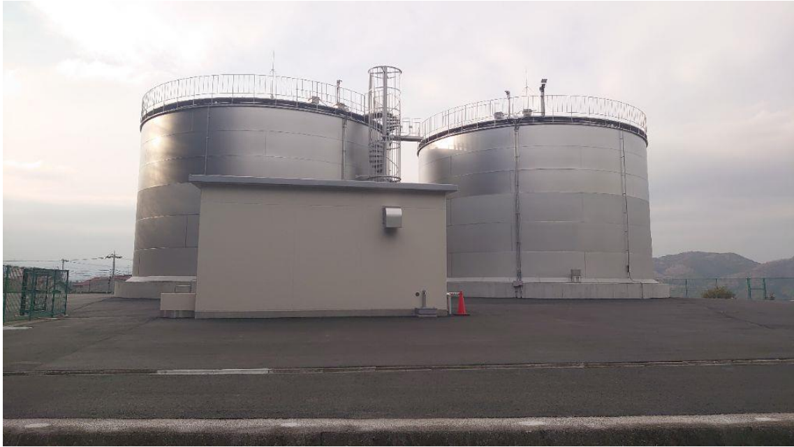
令和 7 年度に完成となった武蔵台配水場。
