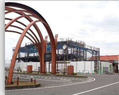
駅舎、自由通路の主要部分の鉄骨組立工事(令和6年6月)
