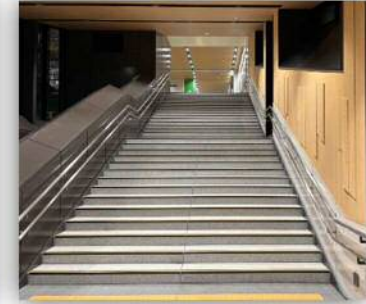
西川材を活用した階段壁面(令和7年11月)
