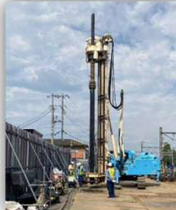
躯体杭基礎工事(令和5年10月)
