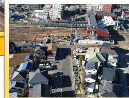
高麗川駅自由通路・新駅舎周辺
