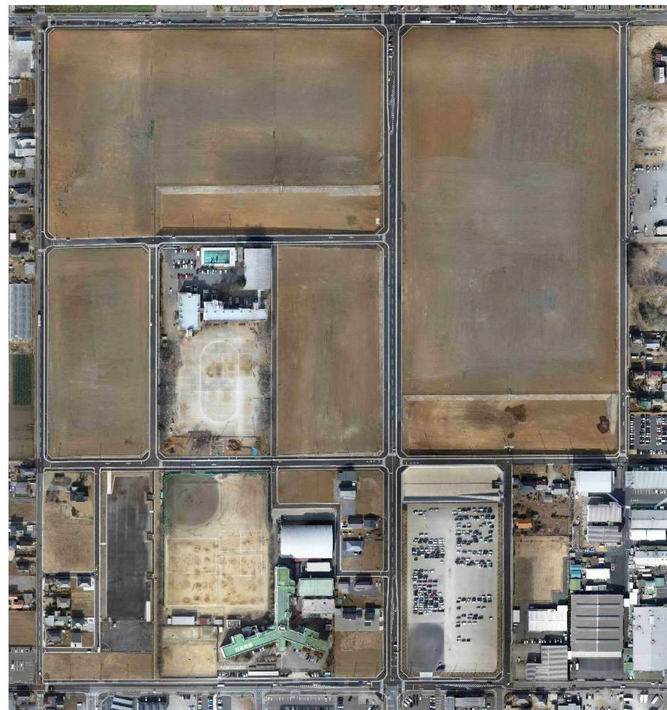
工事完成(2026年2月時点)
