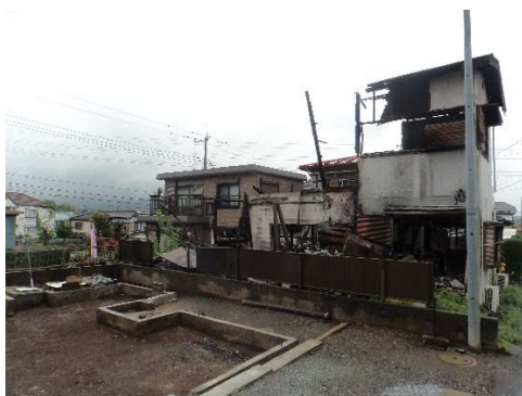
南東側から。車両は撤去済み
