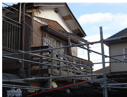
バルコニーの崩落により、エアコンの室外機が落下しかかっている。
