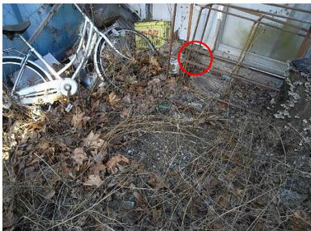
基礎部分が腐食、欠損しており害獣が侵入している。
