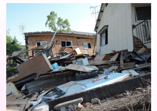
【熊本地震による建物被害】
