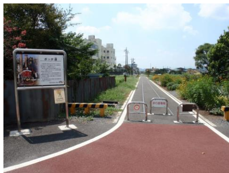
旧引込線を活用したポッポ道
