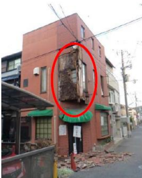
外壁が破損している
