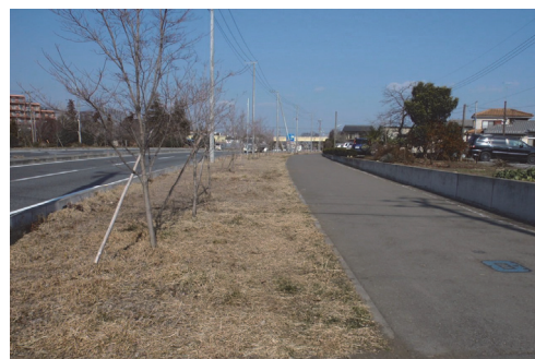
国道407号バイパス線の緩衝帯
