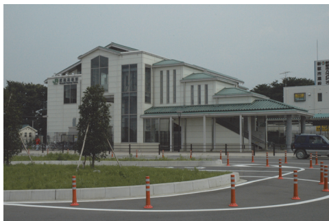
武蔵高萩駅駅舎及び自由通路
