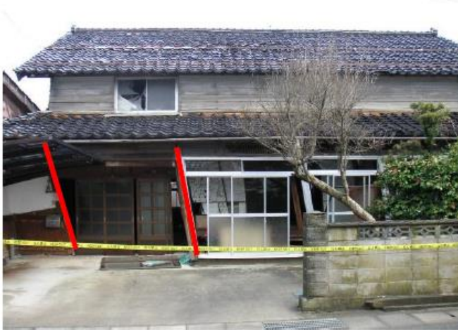
1階部分が傾斜している
