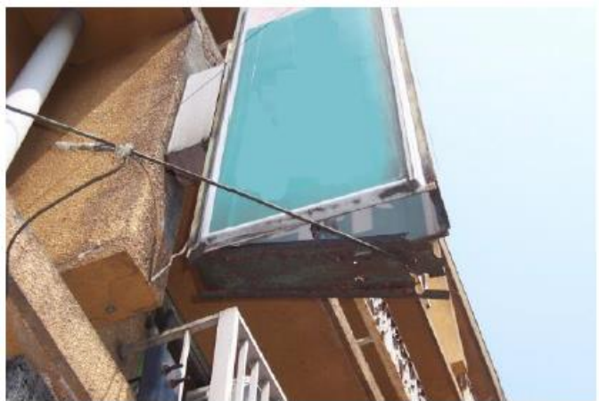
底板に腐食が発生している
