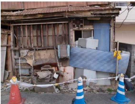
外壁が破損している
