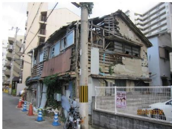
外壁の脱落、屋根ふき材の脱落等
