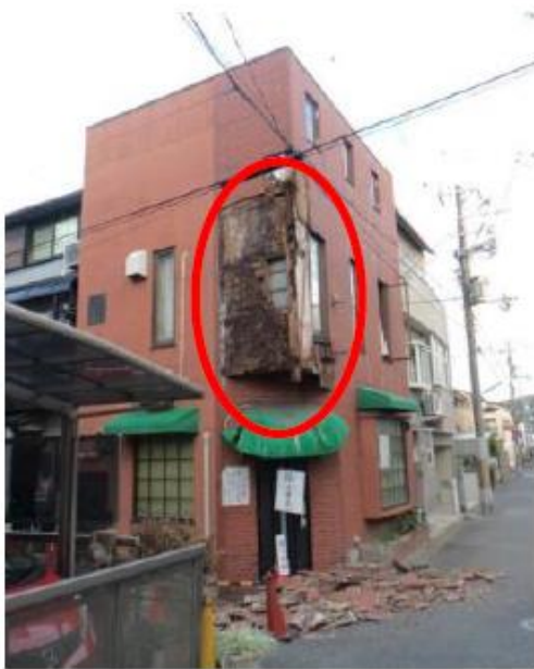
外壁が破損している
