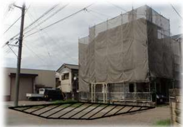
敷地全景（南西から）
