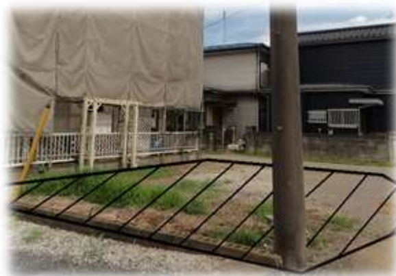
敷地全景（北西から）
