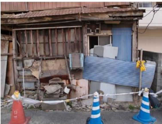
外壁の脱落、屋根ふき材の脱落等
