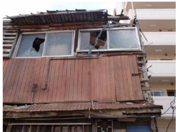
外壁の脱落、屋根ふき材の脱落等
