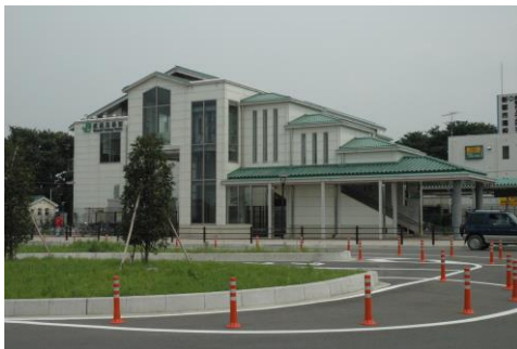
武蔵高萩駅駅舎および自由通路
