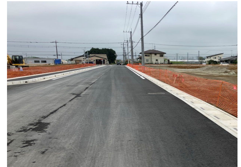
施工中状況 (2025年3月時点)
