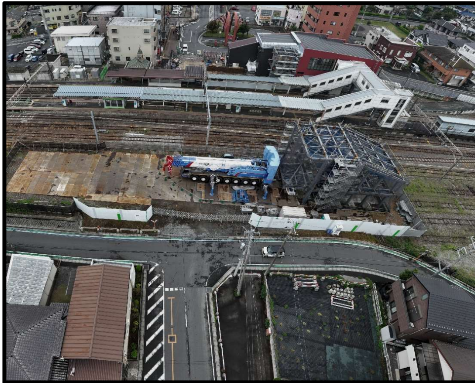
桁の架設前（2025 年 4 月時点）
