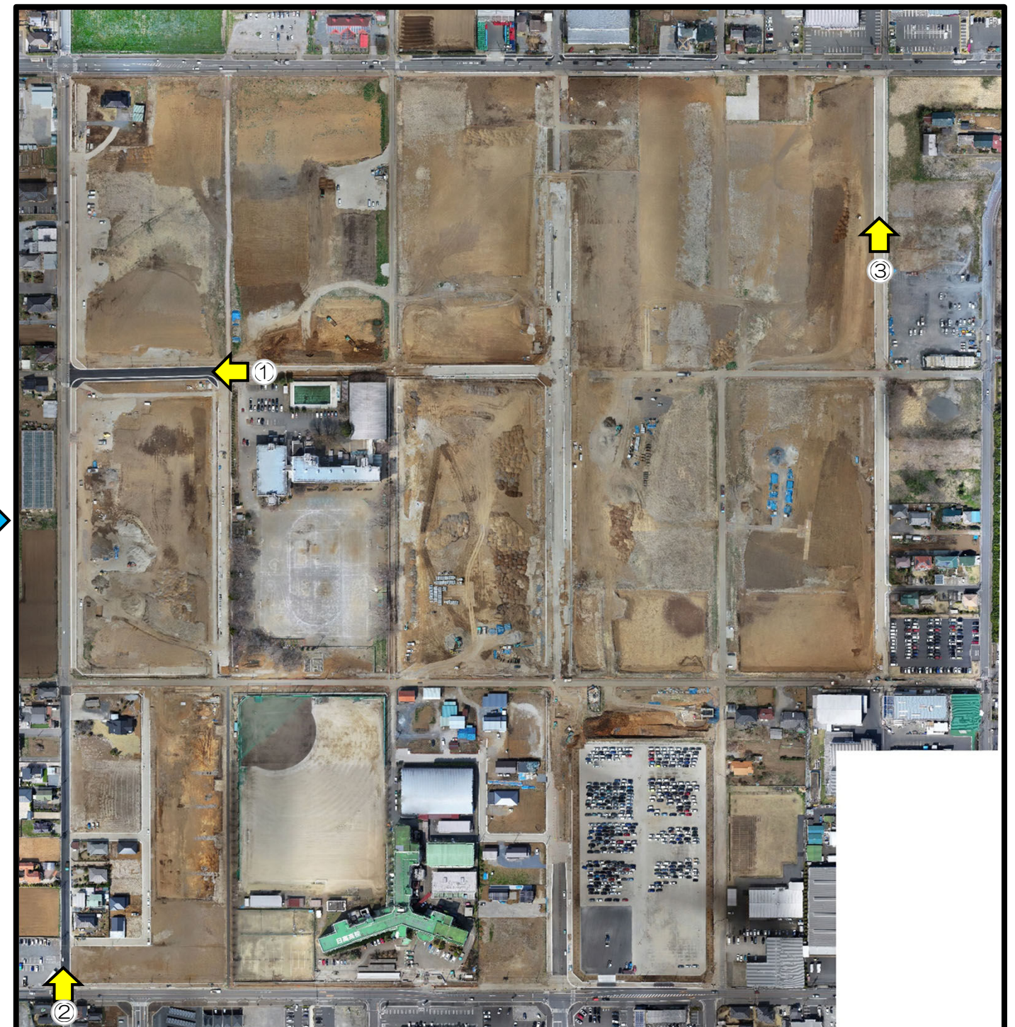
施工中状況(2025年3月時点)
