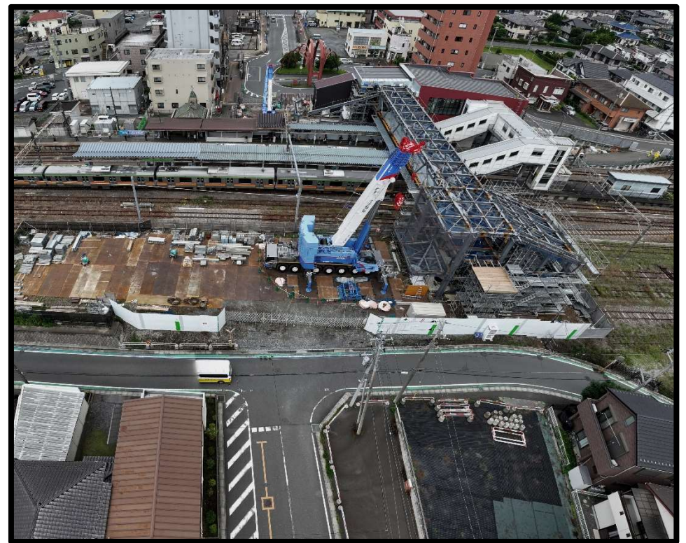
桁の架設後（2025 年 6 月時点）
