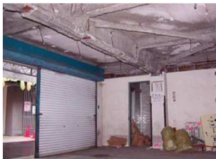
①②吹付け石綿等が飛散し暴露する可能性が高い
