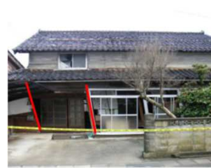
③1階部分が傾斜
