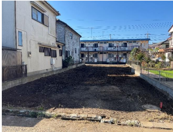
11月14日に解体工事を確認（写真は11月29日撮影）
