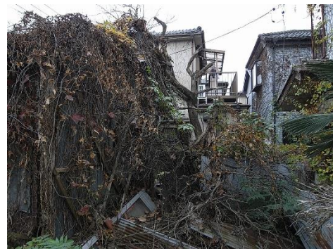
物件 No.6 との間には廃材が散乱。
