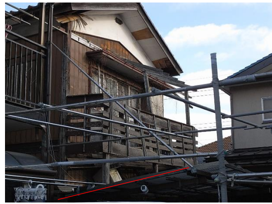
バルコニーの崩落により、エアコンの室外機が落下しかかっている。
