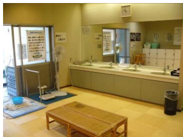
床を張り替えた浴室脱衣所
