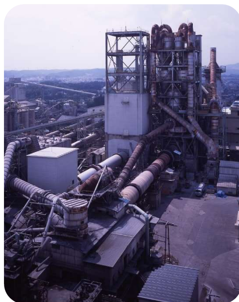
ごみのセメント資源化施設
