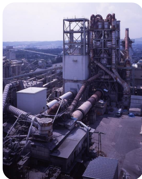
ごみのセメント資源化施設
