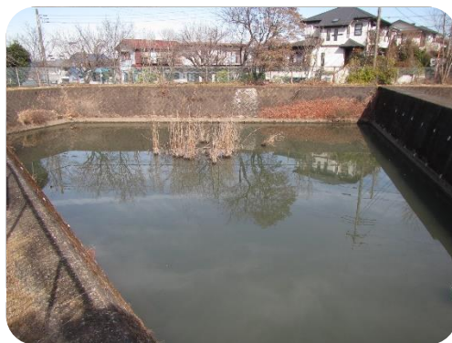
市内の調整池
